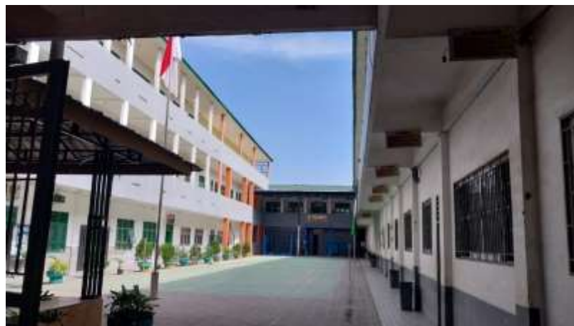
Gambar 3. Kondisi Sekolah Pada SMK Swasta Musda Perbaungan
